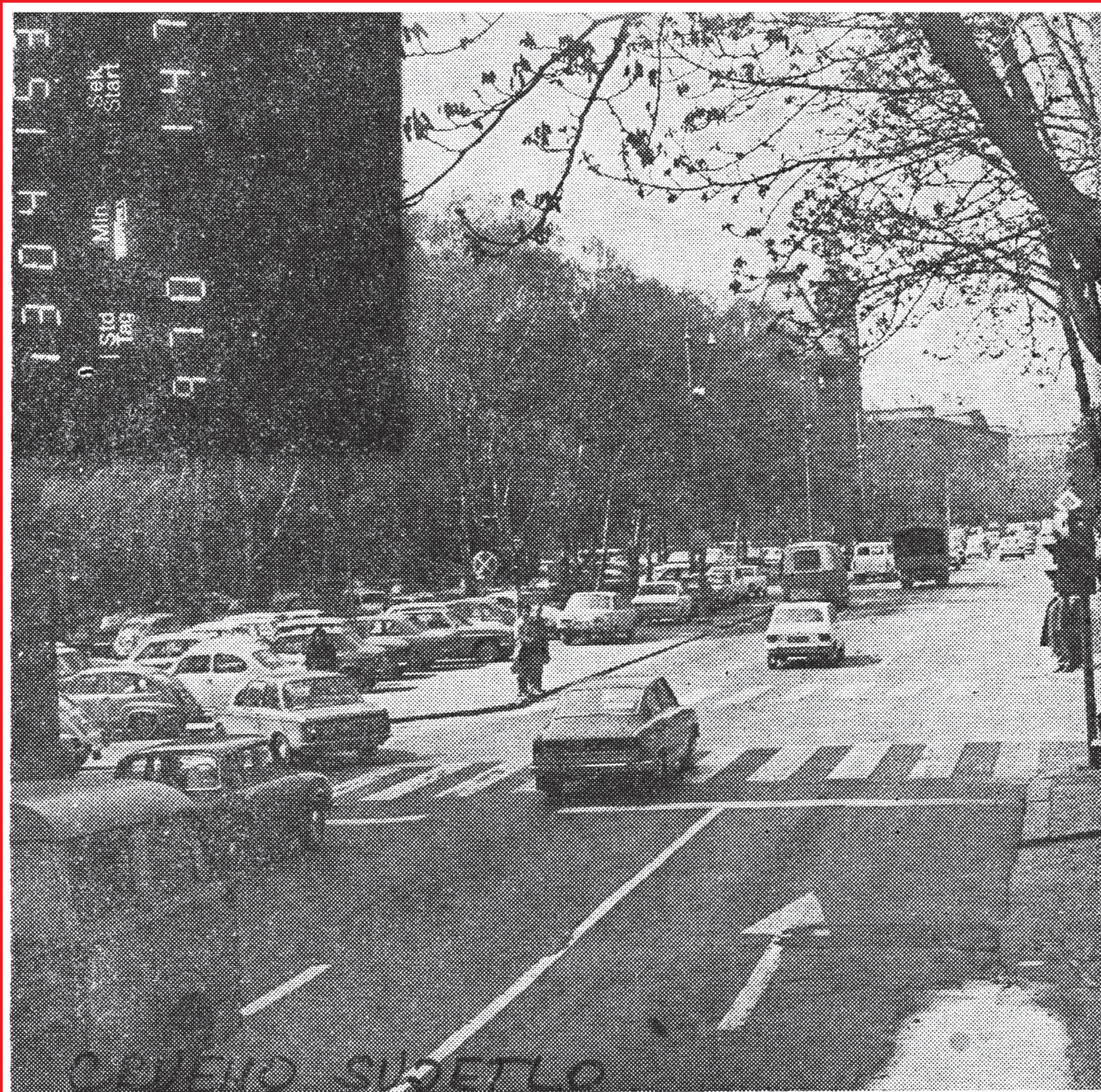
Slika 13 — Prvi snimak ulaska osobnog automobila marke »škoda« u križanje pod crvenim svjetlom. Na semaforu se vidi da je uključeno crveno svjetlo, a u lijevom uglu fotografije da je snimak učinjen u 13 sati, 4 minute i 15,3 sekunde, 97. dana u godini te da se crveno svjetlo upalilo u 13 sati, 4 minute i 14,7 sekundi.
